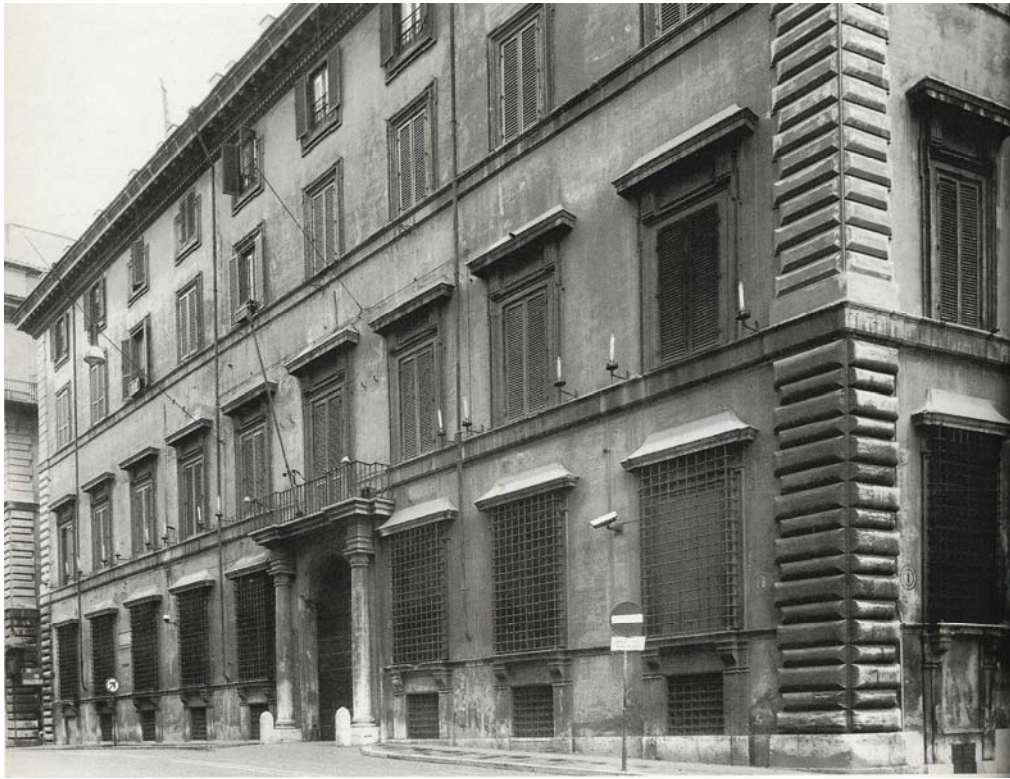
Fig. 2 - La facciata principale di Palazzo Giustiniani a Roma su via della dogana vecchia
